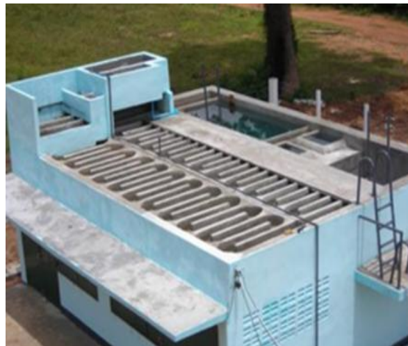
ระบบกรองน้ำประปา ขนาด 10 ลูกบาศก์เมตร/ชั่วโมง
